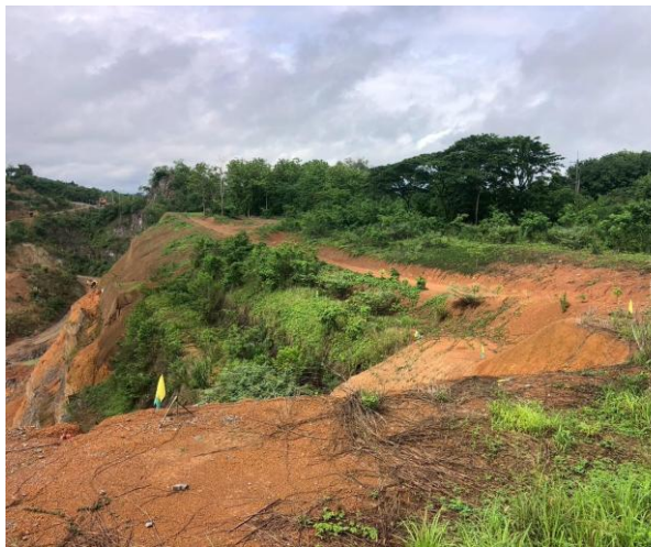
รูปที่ 2-10 ตัวอย่างการนำเปลือกดินมาซ่อมแซมคันทำนบดิน
