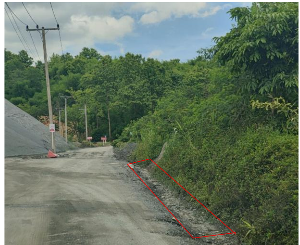
รูปที่ 2-6 (ต่อ) คั่นทำนบดิน ถนน คุระบายน้ำ และบ่อดักตะกอน ที่ใช้เปลือกดินส่วนใหญ่ในการปรับแต่ง
